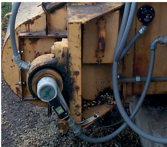
Whirligig instalado en un transportador cerrado, mostrado con un M800 speedswitch.
